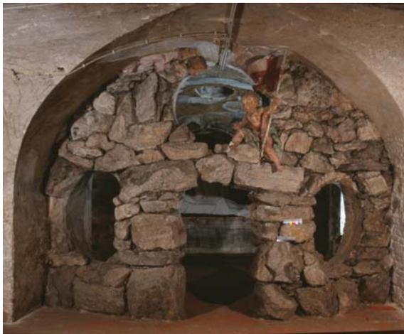
Festigung der Wandmalerei- und Stuckfassung, Wiederanbindung von Stuck- und Putzblasen, Korrosionsschutz freiliegender Stuckarmierung, Strukturfestigung des Putzes, Reinigung der Stuckoberflächen, Ergänzung von Fehlstellen im Putz, Projektierung zur zukünftigen Präsentation und Nutzung
