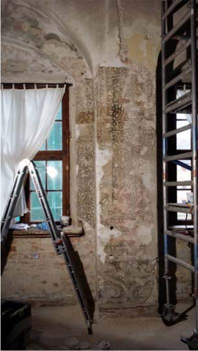
Konservierung, Nachfreilegung an der Westwand, Sicherung der Putze mittels Anböschern und Hinterfüllung, Entfernen sandender Putzergänzungen, Entfernen zementhaltiger Putzergänzungen, Reinigung der Oberfläche, Putzergänzungen mittels Kalkputz unter Niveau, Kartierung und Dokumentation der durchgeführten Maßnahmen
